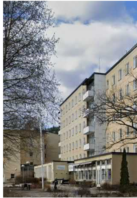
Befintlig puts karaktär och gestaltning.
